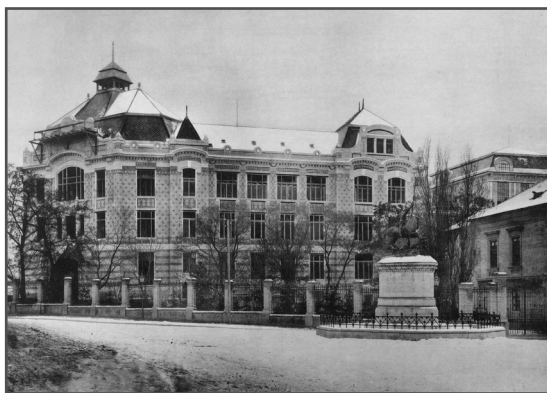
Az új könyvtáráépület keleti homlokzata 1910 körül
